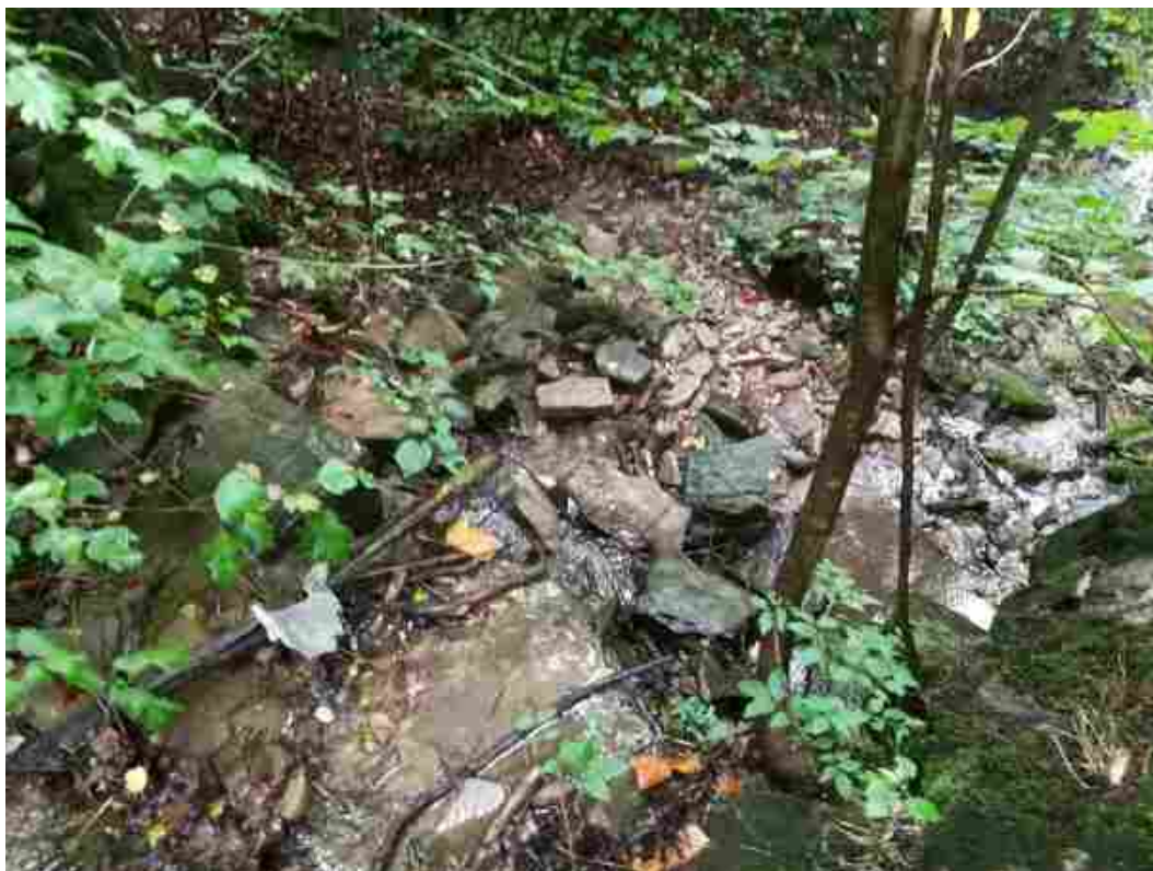
FOTOGRAFIA 5 WIDOK NA STANOWISKO DOLNE ZAPORY
