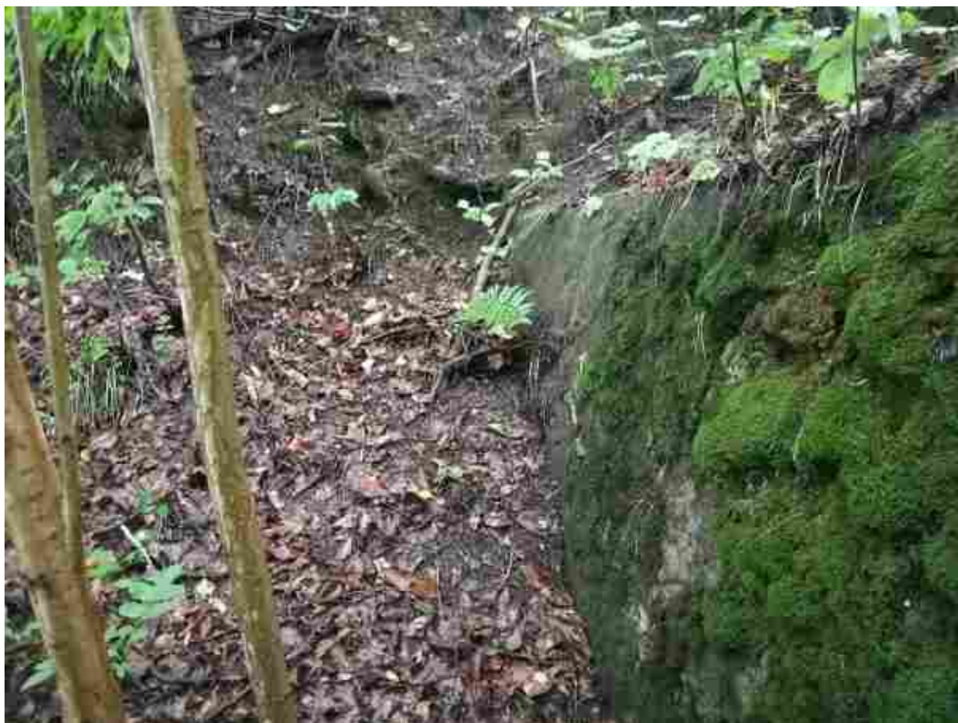
FOTOGRAFIA 3 WIDOK NA PRAWIE SKRZYDŁO OD STRONY WODY DOLNEJ.
