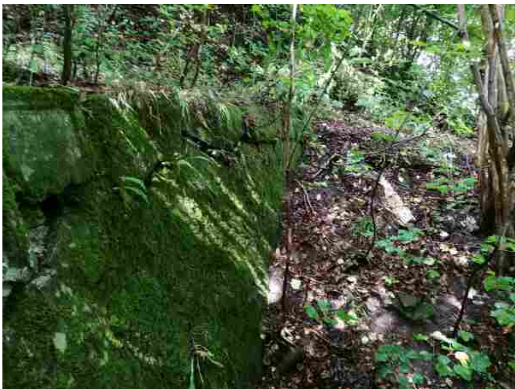
FOTOGRAFIA 4 WIDOK NA LEWE SKRZYDŁO OD STRONY WODY DOLNEJ.
