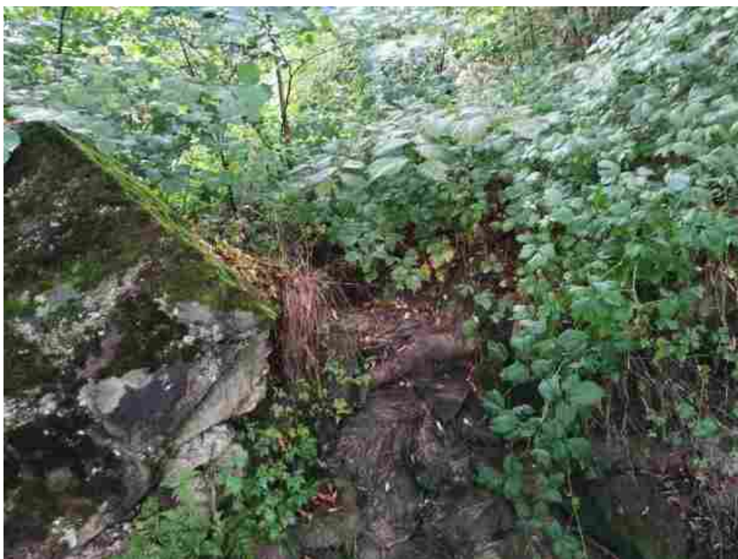
FOTOGRAFIA 2 WIDOK NA PRZELEW OD STRONY WODY DOLNEJ.
